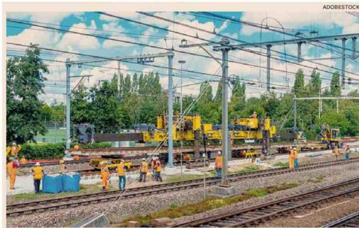
Lavori in corso. Un cantiere ferroviario
