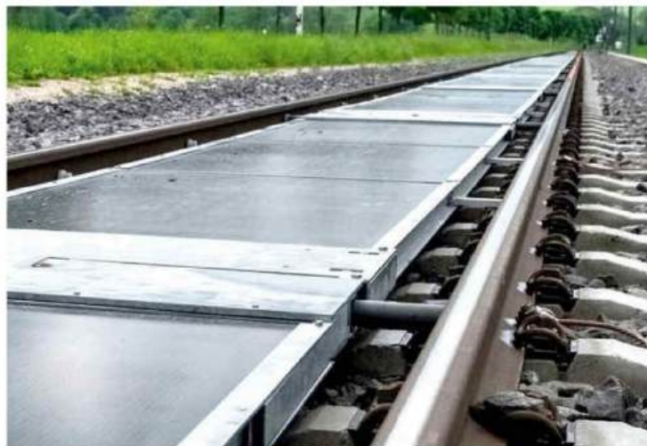
Le traversine I pannelli piazzati fra i binari ferroviari
